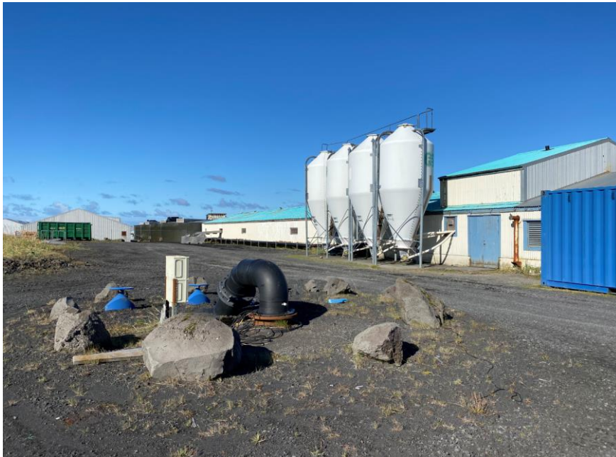
Mynd 3.8 Í forgrunni myndarinnar er ein af mörgum borholum á lóð eldisstöðvarinnar, sem nýtt er til vinnslu grunnvatns. Í náninni framtíð verður byggt hús yfir þessa borholu.
