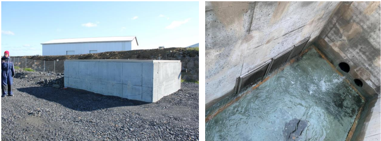
Mynd 3.9 Frárennslispró sem útbúin er með fiskgildru.
