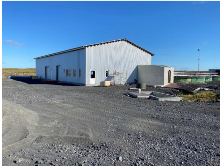
Mynd 3.4 Sláturhús Stofnfisks sem verið er að byggja.
