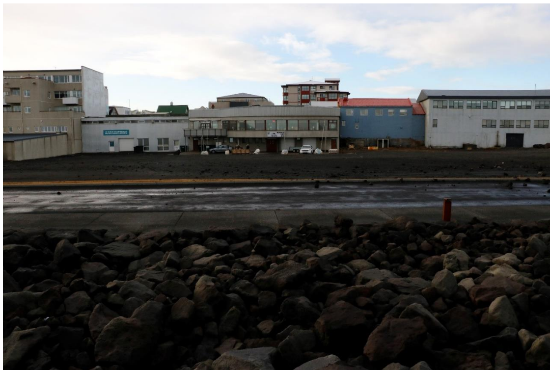
Mynd 10 Bílastæði aftan við byggingar sem standa við Hafnarstræti en snýr að Ægisgötu. Sjá mátti ummerki þess að flætt hefði að þessum húsum (þang og möl) og þjónn á Veitingastaðnum Ráin sagði að í kjallaranum hefði vatn náð honum upp á kálfa.
