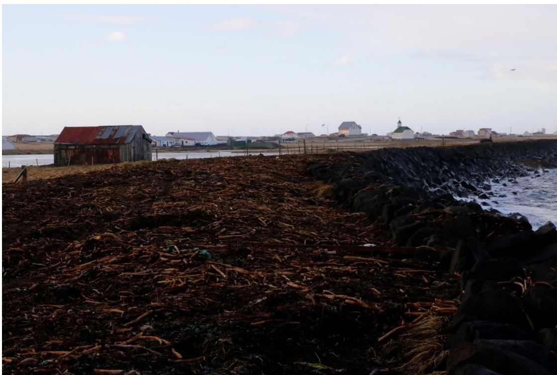
Mynd 12 Þari og rusl sem skolaðist yfir varnargarðinn sem liggur í átt að Garðskagavita.
