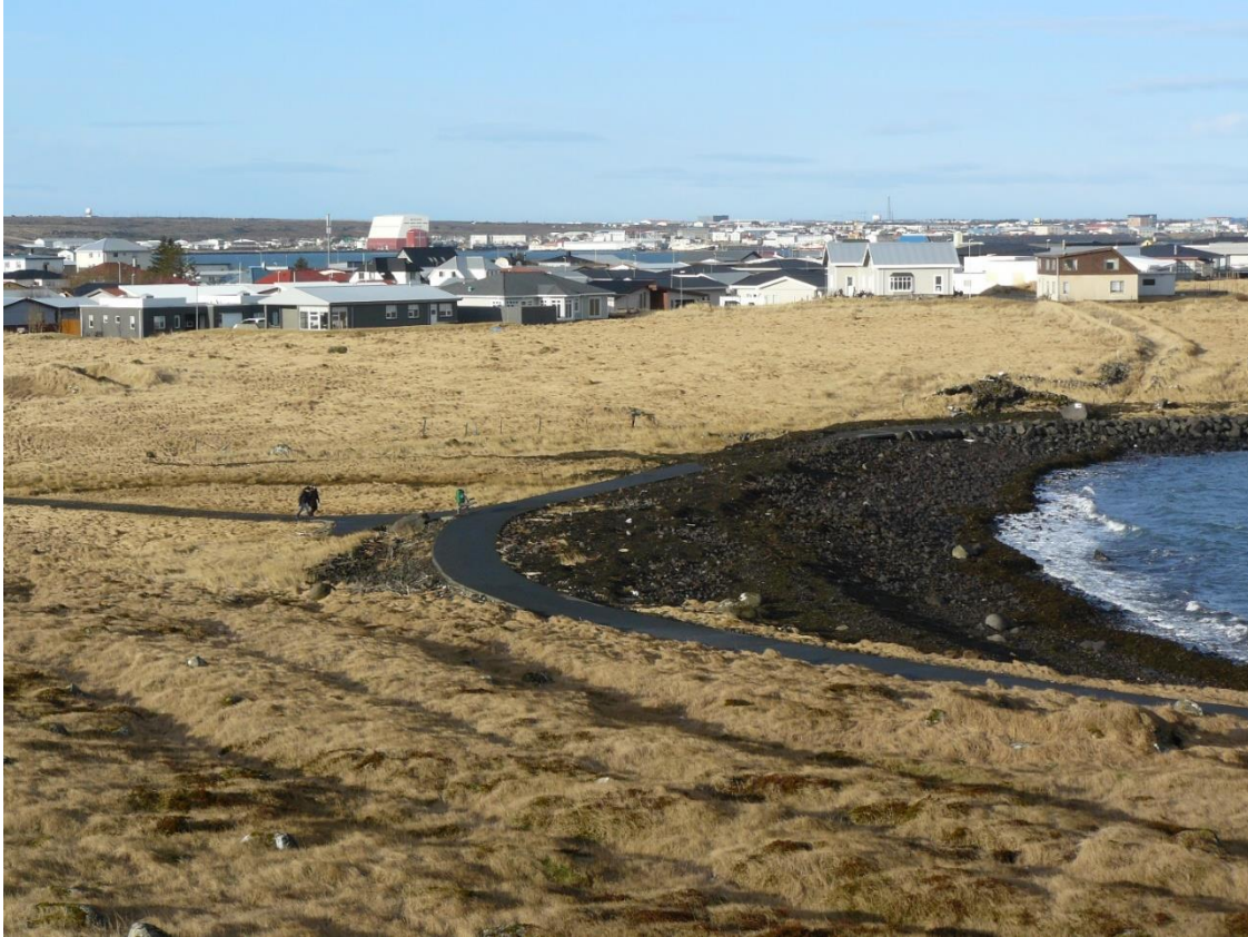
Mynd 2 Yfirlit yfir smávoginn Kópa, fjöruna þar sem grjót og þara hafði skolast á land og varnargarðinn sem byrjar vestan í veginum.
