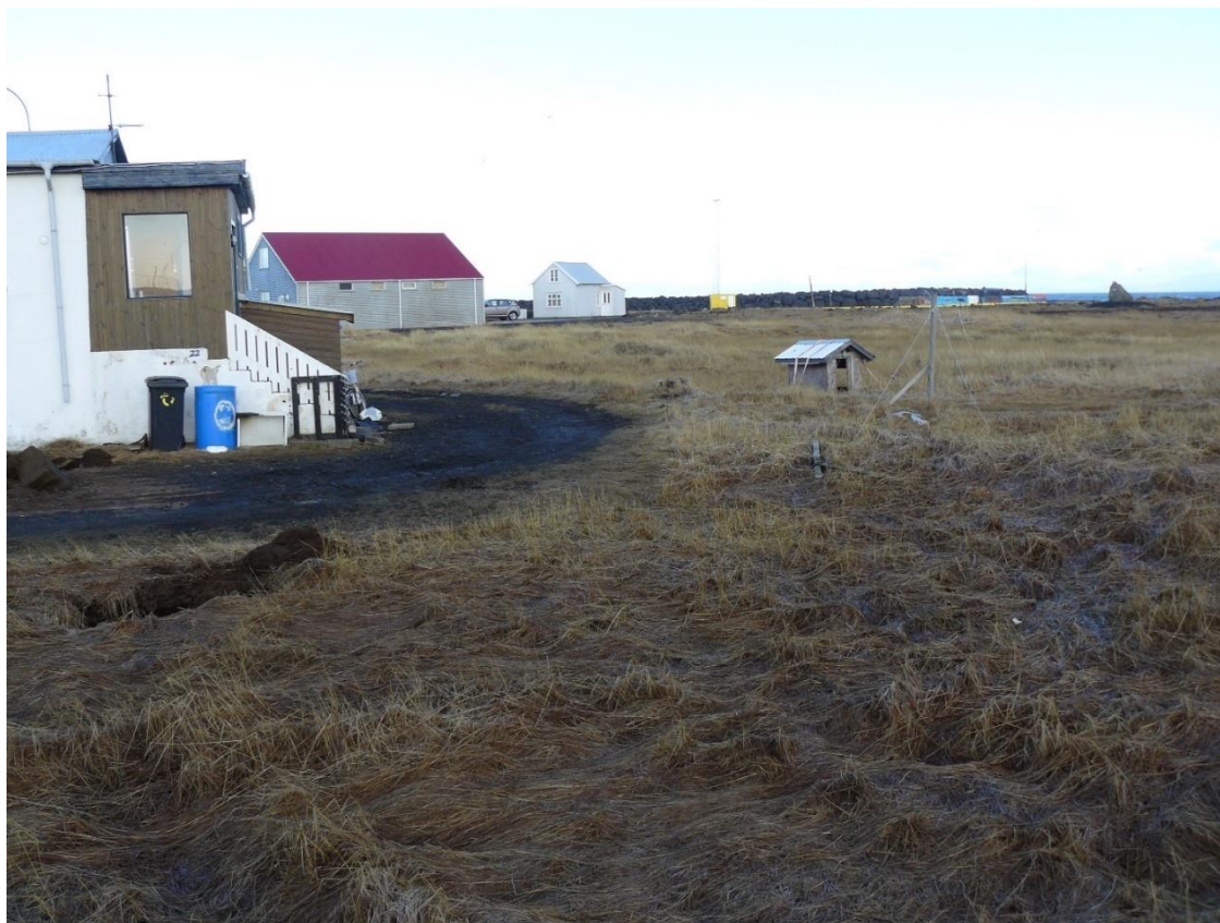
Mynd 15 Garðavegur 22. Sjór flæddi að þessu húsi, en ekki voru mikil merki um flóð við nærliggjandi hús, þó líklega hafi vatnsstaðan einnig náð þeim.
