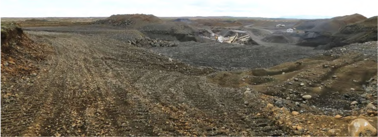
MYND 4.14 Hér er horft yfir núverandi efnistökusvæði í Rauðamel. Öll starfsemi er niðurgráfin í gryfju og það eina sem sést úr fjarlægð eru efnishaugar á gryfjubakkanum. Efnishaugunum verður rutt niður í gryfjuna að efnistöku lokinni og svæðið jafnað út svo ummerki efnistökkunnar verði ógreinileg.
