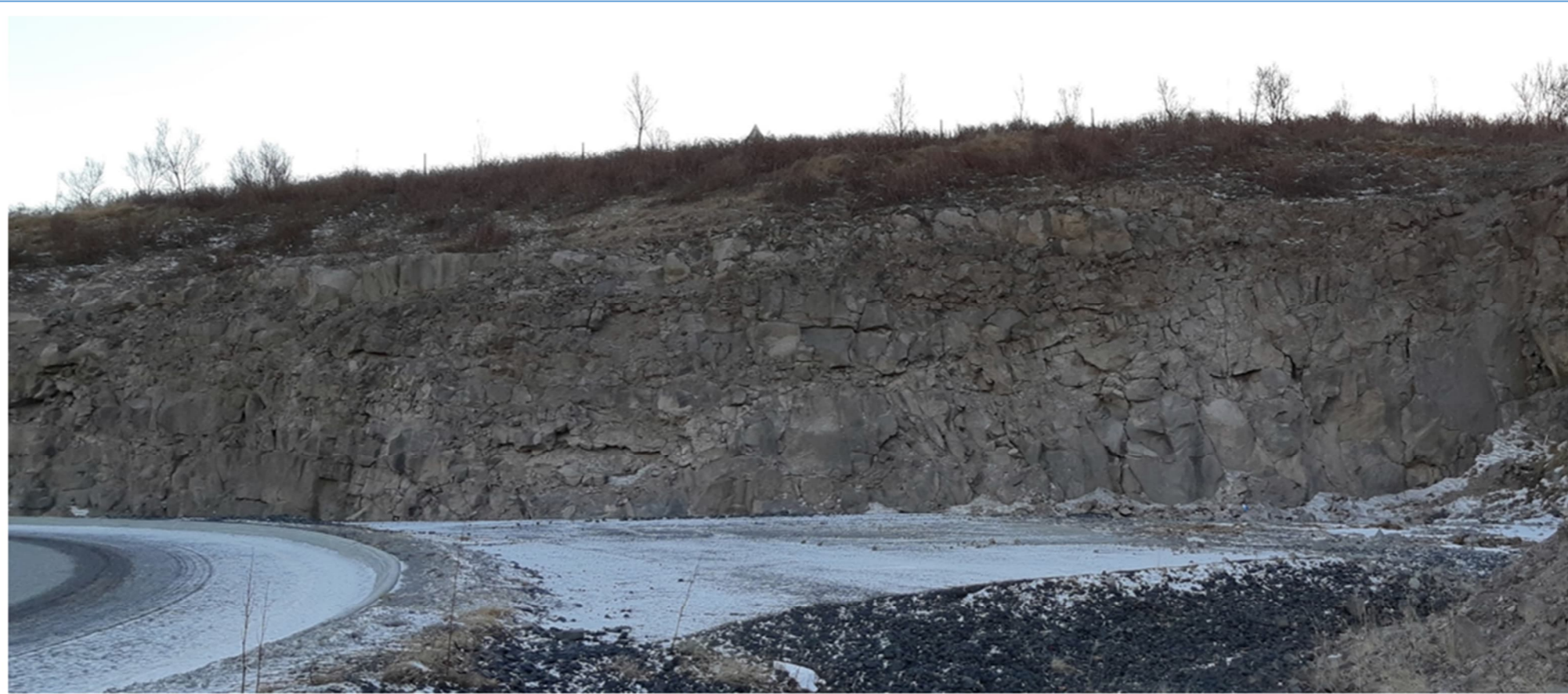
Mynd 2-1 Austurveggur sprengdrar skeringar í grágrýti, nokkrar mannhæðir, sem sýnir breytileikann í jarðmyndun sambærilegri við Háaleitisgrágrýtið. Glaðheimavegsstubbur til S frá hringtorgi á Arnarnesvegi. (Verkís, 2021).
