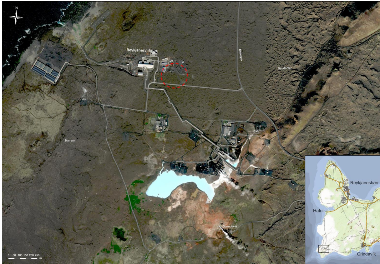
MYND 7.1 FRAMKVÆMDASVÆÐI HÆGRA MEGIN VIÐ HLIÐ REYKJANESVIRKJUNAR Á MYND, INNAN RAUÐA HRINGSINS.
